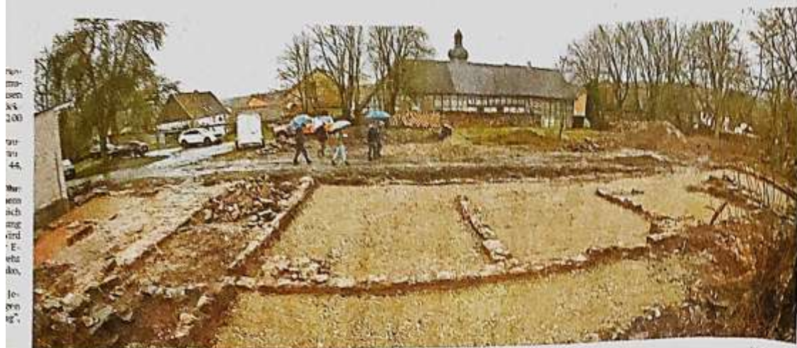
Auf dem ehemaligen Gelände des Schlosses Seidingstadt sind Reste der Mauern eines Flügels freigelegt worden.
