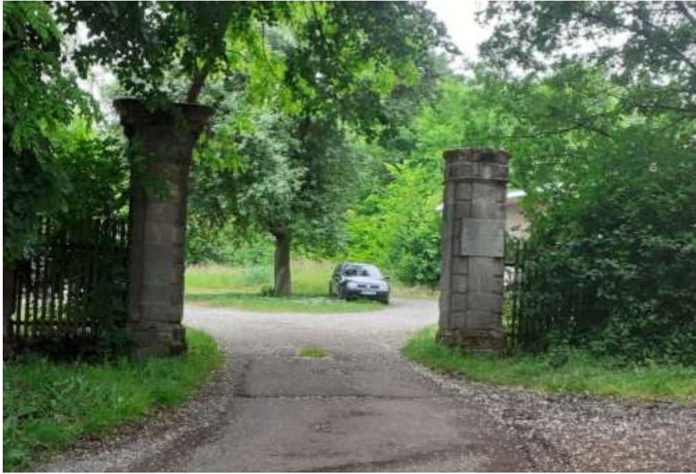
Einfahrtspfeiler vor der Restauration Linker Pfeiler mit Kapitell, rechter Pfeiler ohne Kapitell
