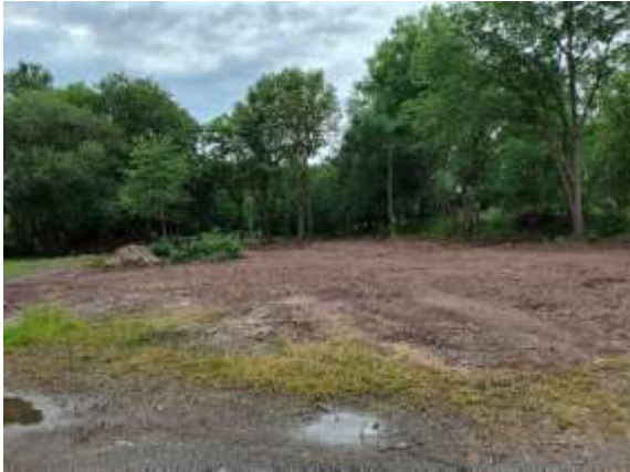
Schlossfläche nach Abschluss der Rodung von Wurzelstöcken
