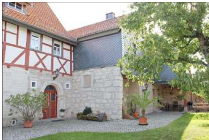
Ein gutes Beispiel für die nachhaltige Sanierung eines alten Anwesens mit Hoffläche in der Stadt Heldburg: Haus Hunstock (Baukulturpreisträger 2020 der Initiative Rodachtal e.V.) Foto: Hunstock
