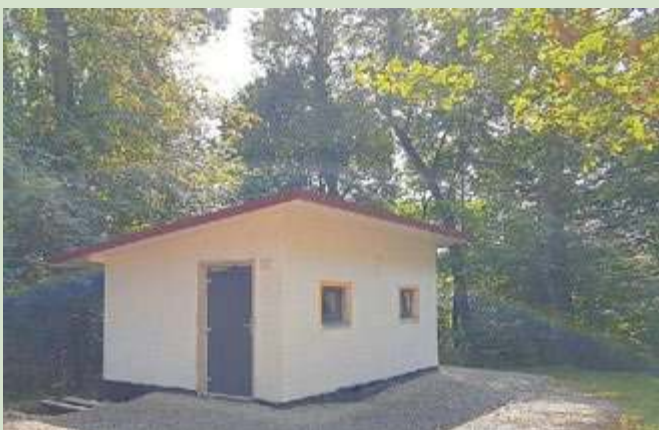
Neue Toilettenanlage Schlosspark Seidingstadt
