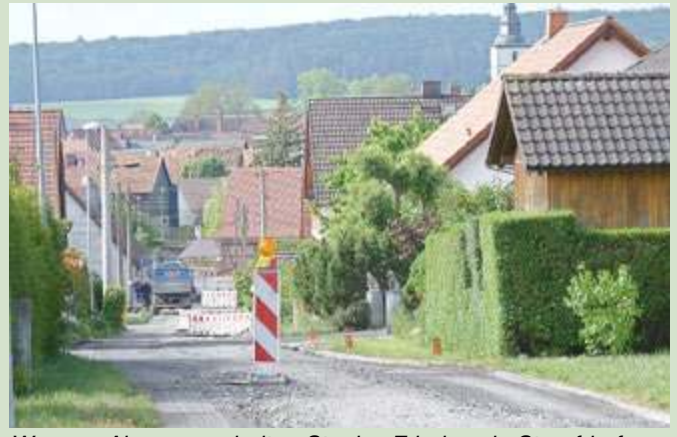
Wasser- Abwasserarbeiten Str. des Friedens in Streufdorf
