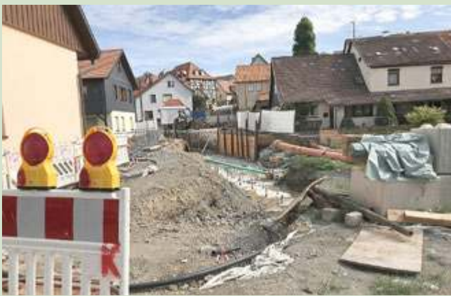
Sanierung Brücke Spring in Steinfeld
