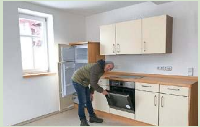
Sanierung Bürgerhaus Seidingstadt – neue Küche
