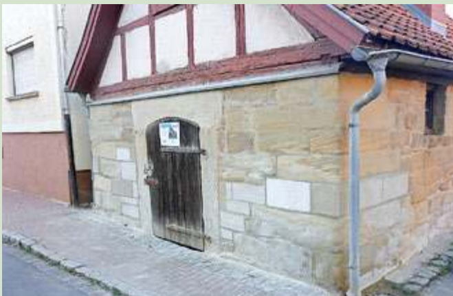
Backhaus Stressenhausen - Sandsteine saniert
