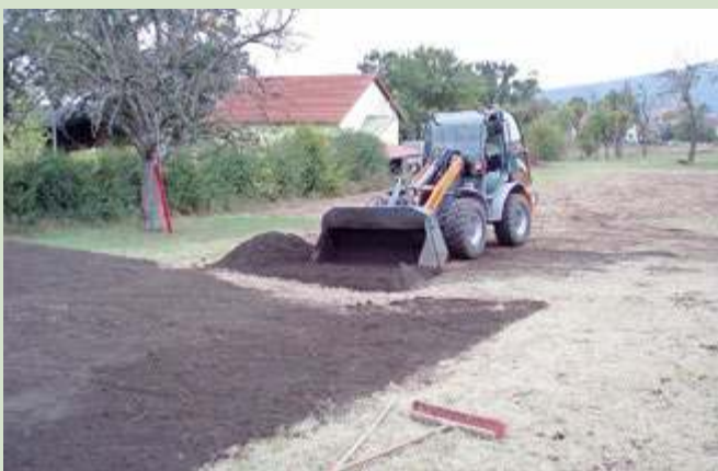
Der Bolzplatz in Linden entsteht mit Hilfe des neuen Radladers
