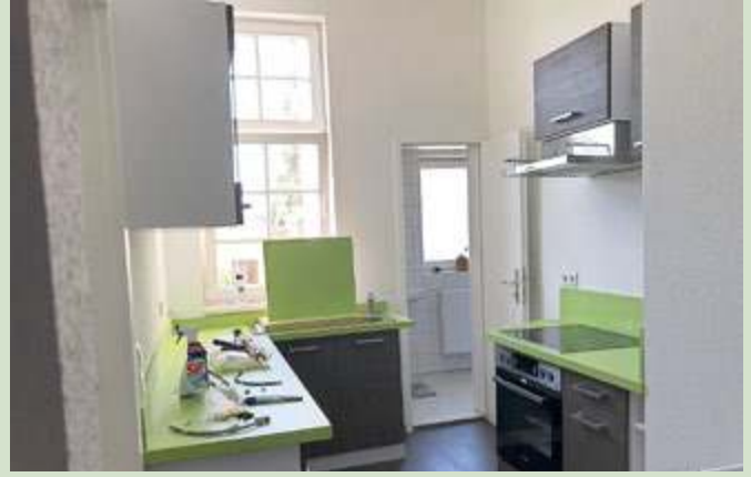
Wohnungssanierung Steinfeld Coburger Str. 1
