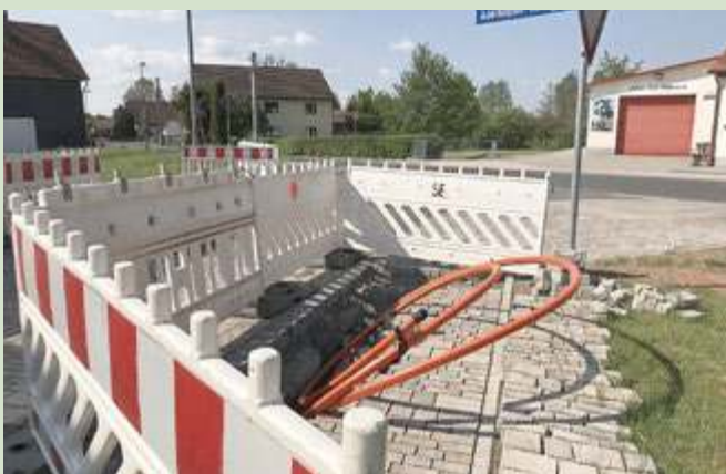
Der Breitbandausbau in der Gemeinde geht voran
