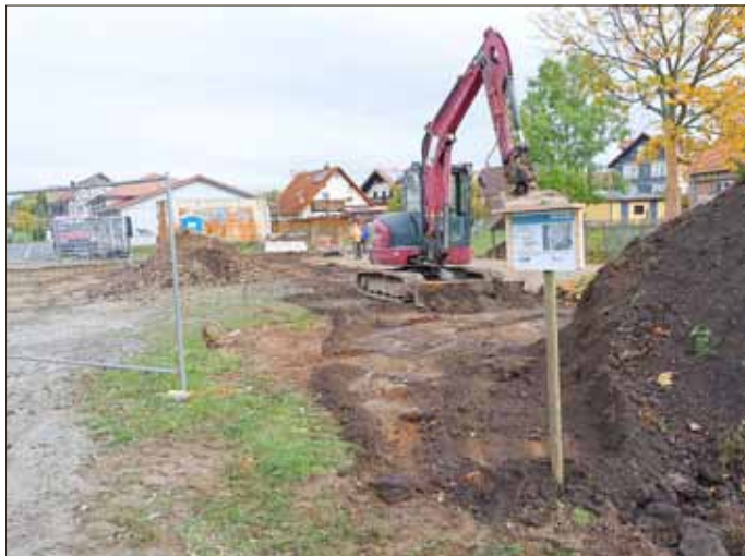
In der Bauphase
